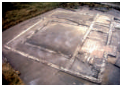
Le site des thermes avant et après restauration.
